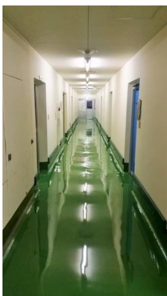
中動物試験棟(3号館)内観
