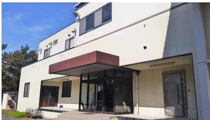
中動物試験棟(3号館)外観
